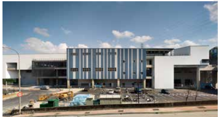
第二棟倉庫全景
