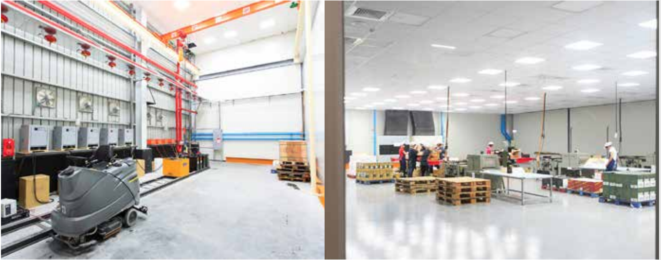
其他功能設施 獨立通風充電站、包裝加值作業區
