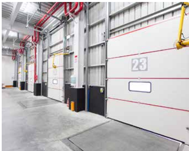
裝卸區 裝卸碼頭、卸貨專用升降板、貨櫃車專用卸貨滑昇門門封、小貨車卸貨平台。
